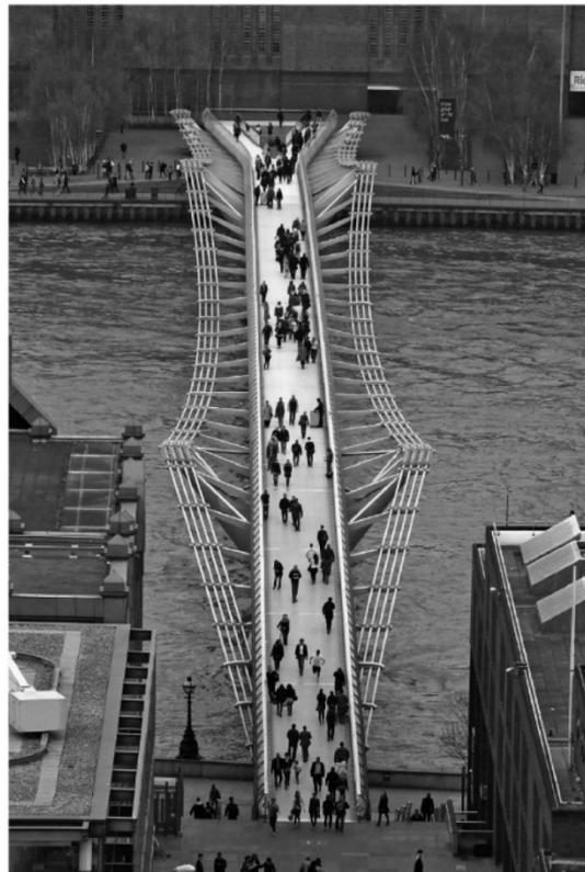
La première partie du sujet était une étude mécanique type « Sup » : modélisation par un système de ressort avec force de frottements visqueux, où l'on montrait que le pont basculait en résonance en fonction de la fréquence des pas des piétons.
